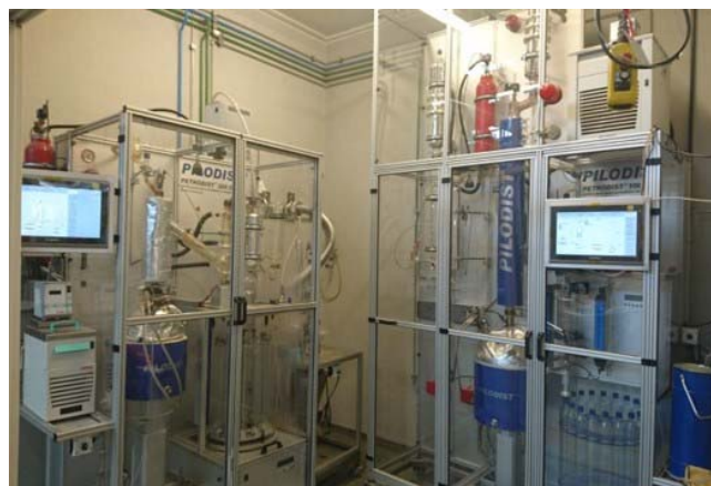
Vista de la planta de destilación.
